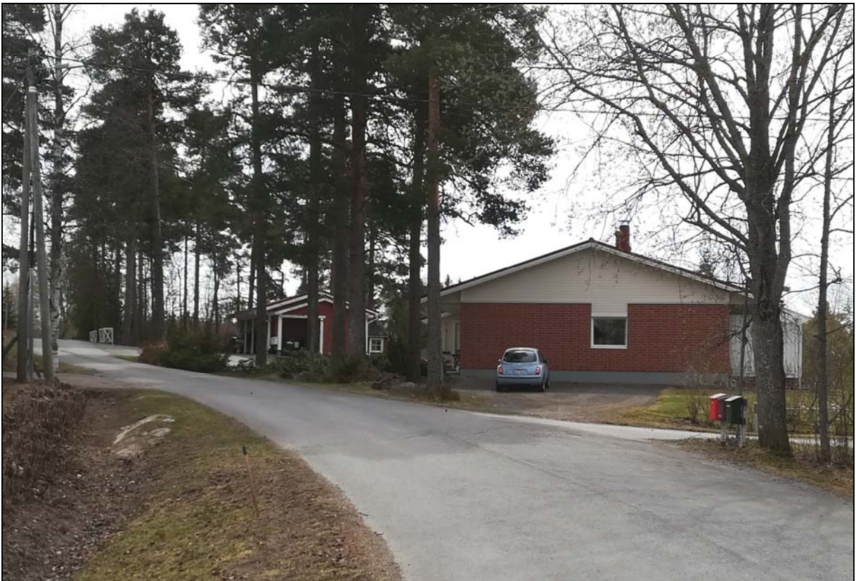
Näkymä Yökkömäentieltä vastakkaisesta puolelta, Kehityksentien suunnasta kuvattuna. Tien viereiselle Vaaran (4:304) kiinteistölle on rakennettu rivitalo ja autokatos. Pöytyän kunnanhallitus myönsi poikkeamisluvan rivitalon rakentamiseksi vuonna 2009.
