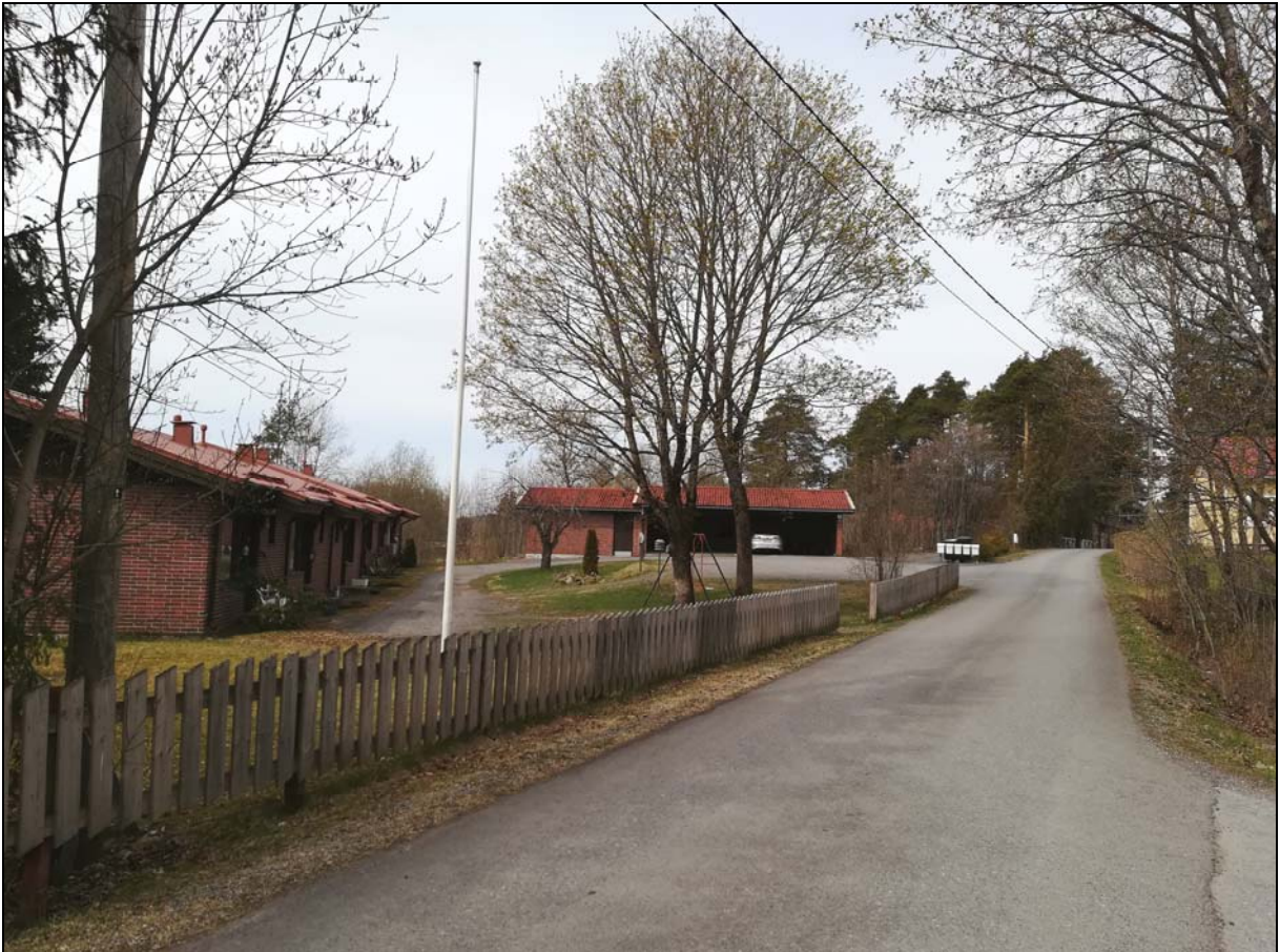
Näkymä Yökkömäentieltä Kyröntien suunnasta kuvattuna. Vasemmalla on kiinteistölle Jänis (4:280) rakennettu rivitalo ja sen autokatos. Poikkeamislupa rivitalon rakentamiseen myönnettiin vuonna 1987.
