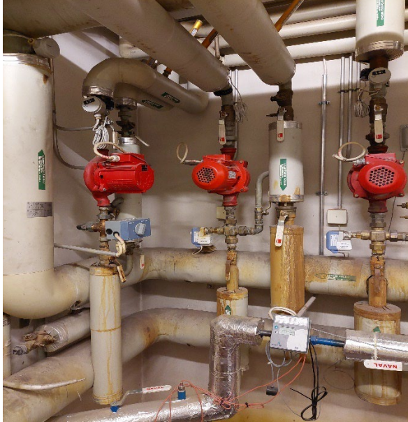
Kuva 3. Lämpöjohdot alakatossa, hieman korroosiota kierreosissa.
