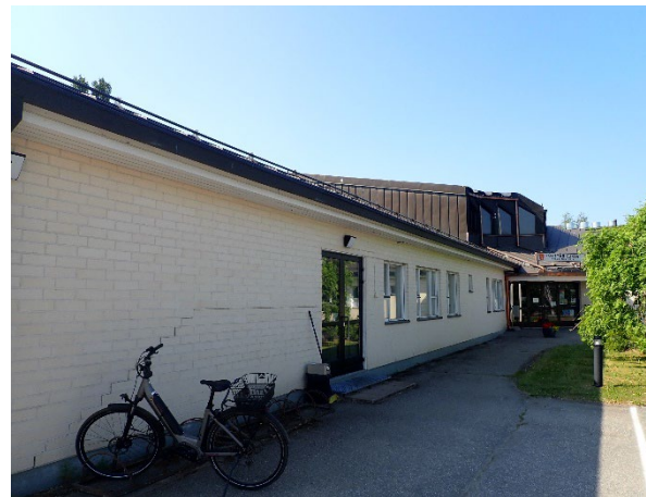
Kuva 46. Valtuustosalin katto on kuparirakenteinen.
