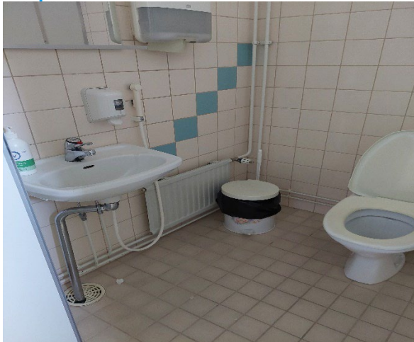
Kuva 5, WC vesijohdot kupariputkia. Vesikalusteet alkuperäisiä.
