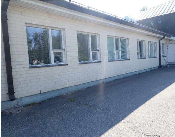
Kuva 29. Rakennuksen ikkunat ovat käytäväosilla alkuperäisiä puuikkunoita.
