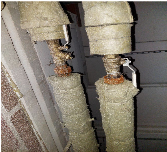
Kuva 3. Lämpöjohdot alakatossa, hieman korroosiota kierreosissa.
