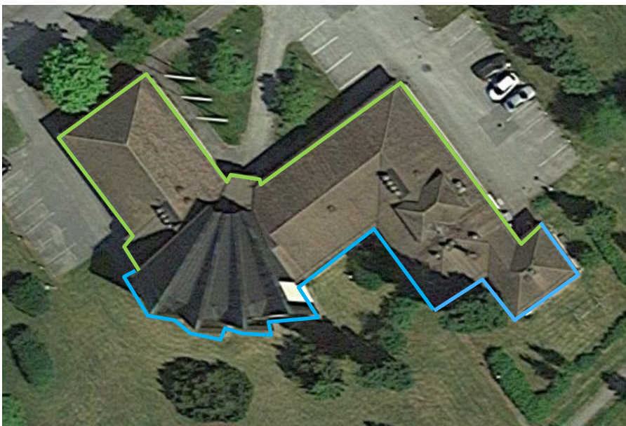
Kuva 2 Kuvassa on esitetty erilaiset vierustäytöt. Vihreällä on esitetty asfaltoituidut ja sinisellä sorastetut.
