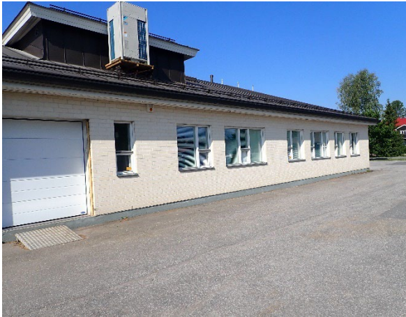
Kuva 14. Rakennuksen ulkoseinät ovat pääsääntöisesti tiili-villa-tiili-rakenteisia.
