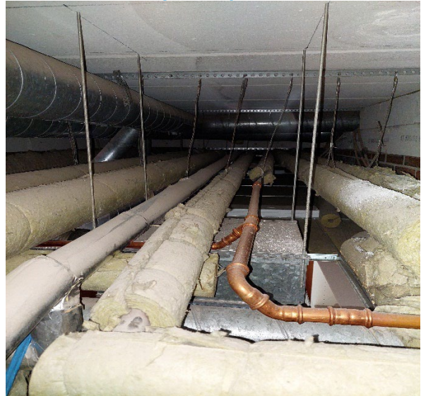
Kuva 4. Uusittu käyttövesiputkea.
