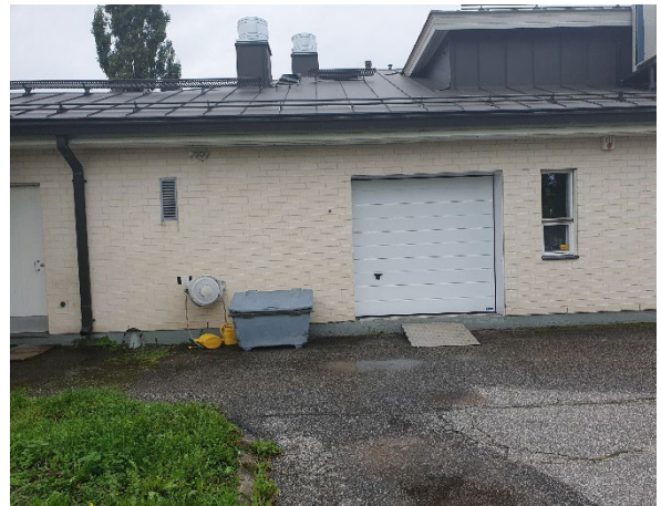
Kuva 28. Autotallin ovi on uusittu kesällä 2023.
