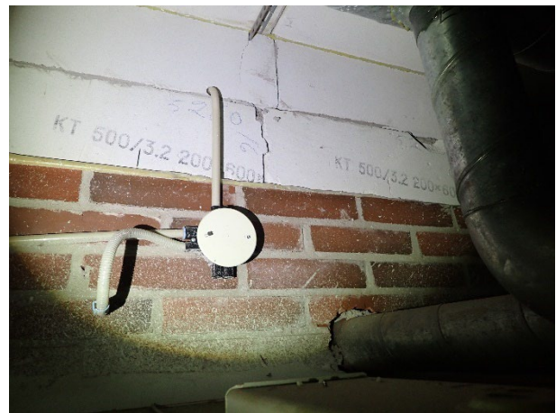
Kuva 49. Väliseinien yläosat ovat harkkorakenteisia.
