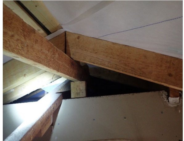
Kuva 36. Aluskate on asennettu melko kireälle.
