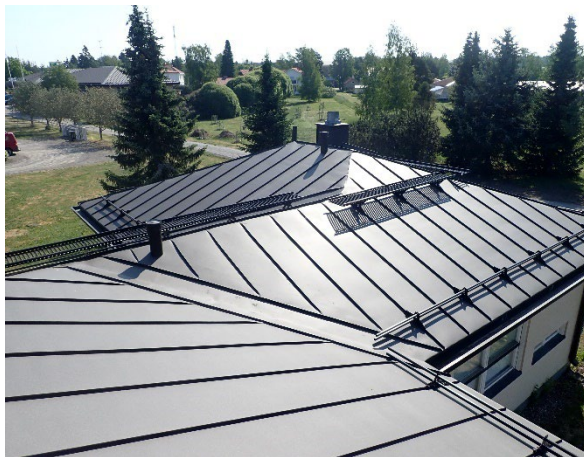
Kuva 45. Toimistosiipien katon on uusittu peltikatteiseksi vuonna 2022.
