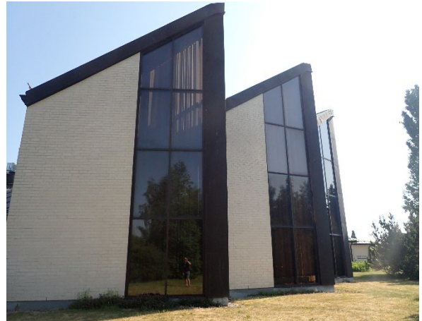
Kuva 15. Valtuustosalin ulkoseinät ovat puurakenteisia ja julkisivut ovat tiiltä sekä kupariverhoilua.
