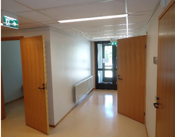
Kuva 56. Huoneiden ovet ovat puuovia.
