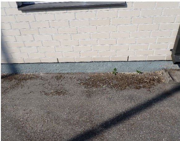
Kuva 16. Alimman kerroksen joka neljäs pystysauma on jätetty auki.
