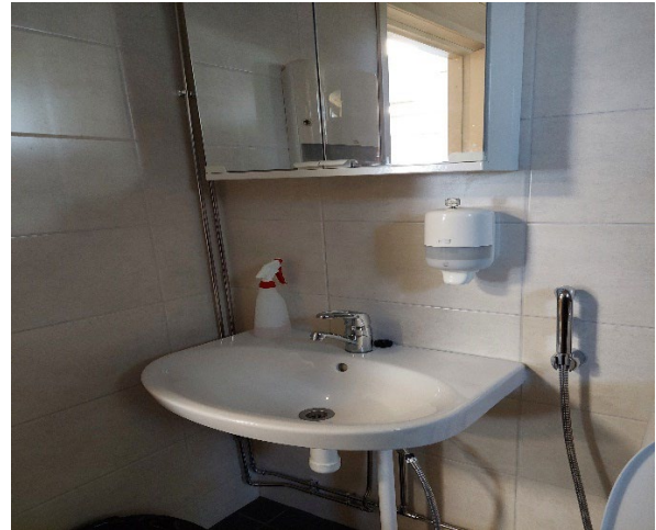
Kuva 6. Asunnossa tehty remontti ja putket ja vesikalusteet uusittu.
