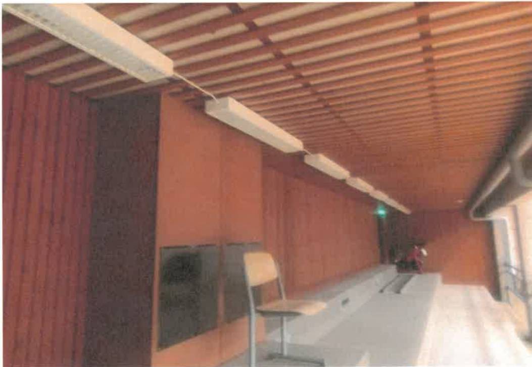
Kuva 5: Näkymä katon ja seinän liittymään, vesivahinkokohta. Katon levyjen irrotus, liimajäämien poisto siporex-elementistä ja pinnan puhdistus ennen uuden akustolevytyksen kiinnitystä. Yläosassa harvempi rimoitus.
