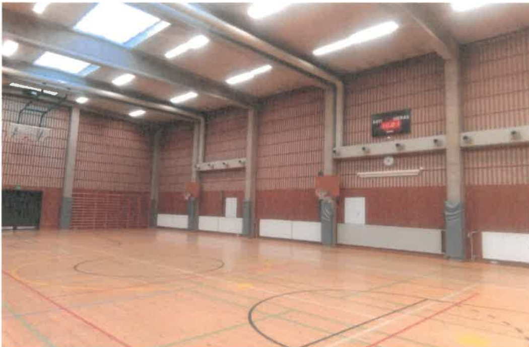
Kuva 8: Kattoikkunoiden alaosa puhdistus yläpuolelta ja kattovalaisimien uusinta (6 x 4 kpl). Lattian suojaus esim. vaneroimalla+ laakerointikerros alle.
