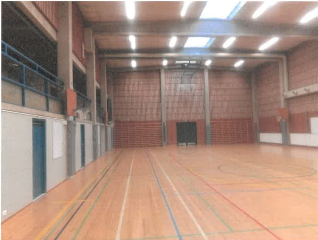
Kuva 4: Näkymä hallin toiseen päättyyn, jossa puolapuut ja ovi ulos. Asennusten ja rimoituksen poisto. Kattoikkunan alaosan levytyksen poisto, elementtien puhdistus ja uudelleenasetus.
