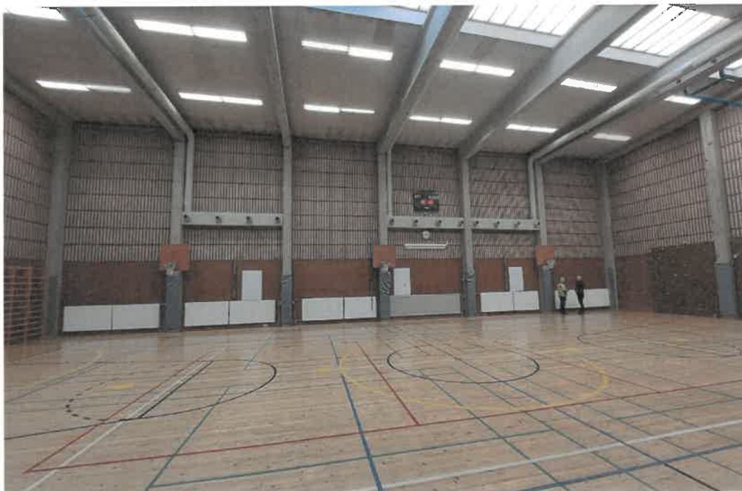
Kuva 2: Näkymä halliin katsomon puolelta, asennuksia seinällä, mm. IV-laitteet ja patterit, jotka poistetaan akustolevytyksen ajaksi, samoin rimoitus, näyttö yms.
