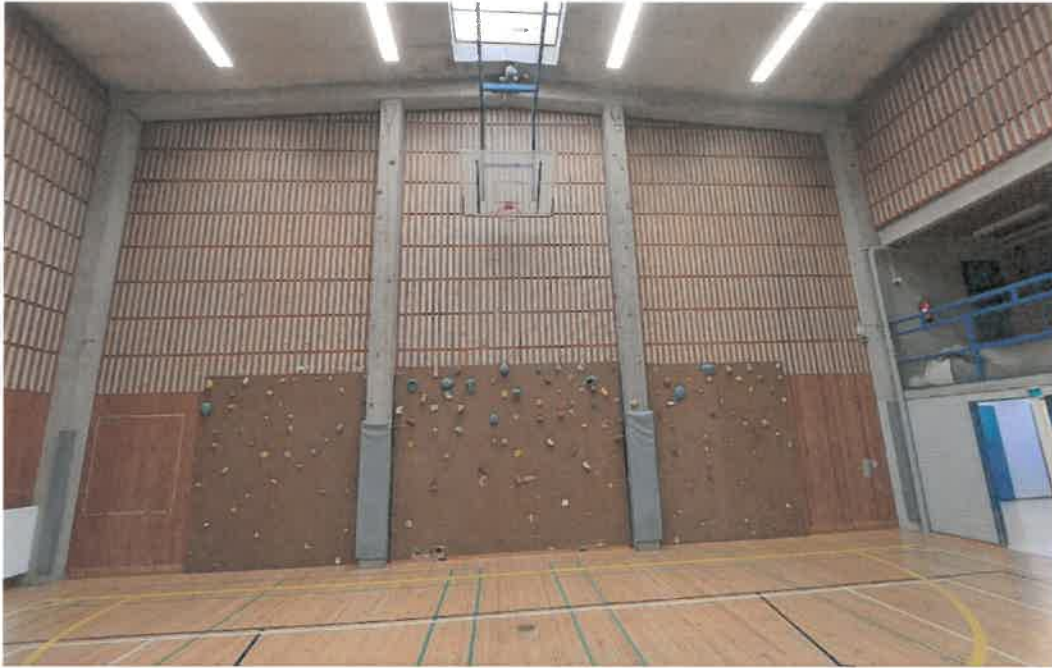
Kuva 3: Näkymä hallin päättyyn, jossa kiipeilytelineet ja muut asennukset poistetaan, samoin rimoitukset.
