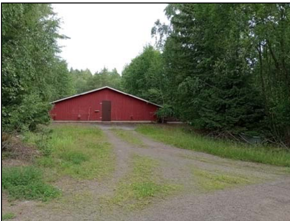
Kompostointilaitos rakennettiin vuonna 1999.
