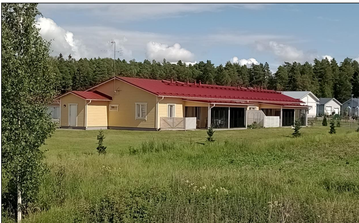
Nissilän asuinalueelle on noussut kaksi yksikerroksista, harjakattoista rivitaloa autokatoksineen. Ne valmistuivat varsin pian nykyisen asemakaavan hyväksymisen jälkeen, vuonna 2017. Molempien suunnittelijana toimi rakennusarkkitehti Hannu Vaisto Aurasta. Rakennukset muodostavat yhtenäisen pihapiirin, mutta ne ovat silti erillisillä kiinteistöillä sijaitsevia taloyhtiöitä.
