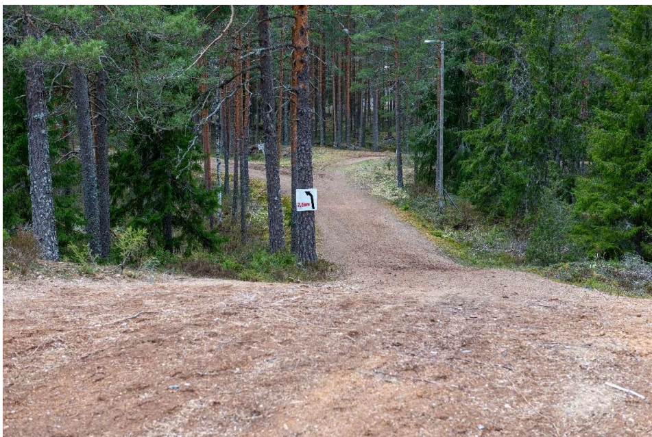
Saneerauksen tarpeessa olevaa reitistöä
