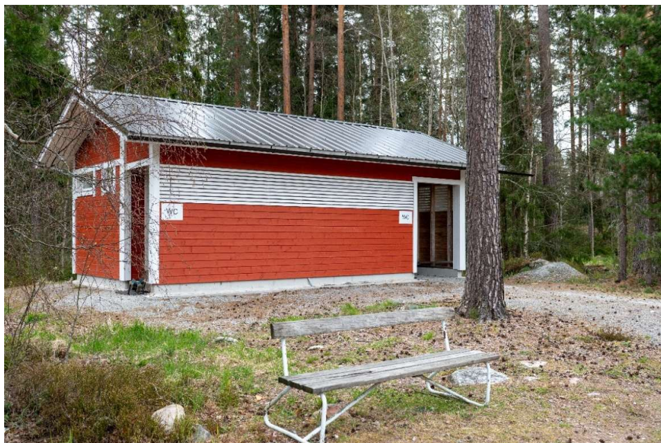
Vuonna 2021 rakennettu biokompostikäymälä
