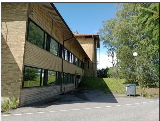
Pienen takapihan puolella näkyy, että rakennus sijoittuu osittain rinteeseen. Toimistosiiven nauhaikkunat olivat aikanaan tavanomainen ratkaisu.
