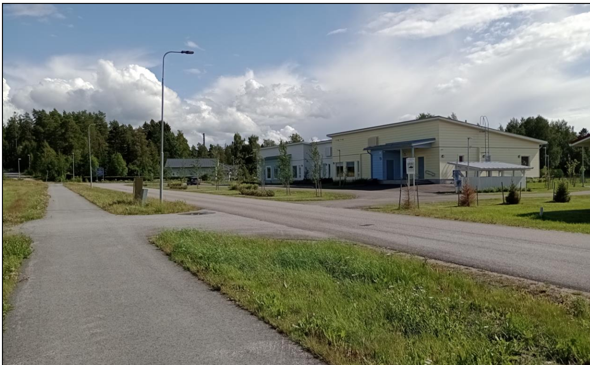
Yläneen uusi päiväkotiki eli varhaiskasvatusyksikkö sijoitettiin Nissiläntien eteläpuolelle. Rakennus otettiin käyttöön vuoden 2021 syksyllä. Julkisivuiltaan kaksivärinen, hirsirunkoinen rakennus on pääosiltaan pulpettikattoinen. Kaksiosastoinen päiväkotiki tehtiin KVR-urakkana. Rakennussuunnittelusta vastasi oululainen Avario Oy, jonka pääsuunnittelijana tässä hankkeessa oli arkkitehti SAFA Tero Aalto.
