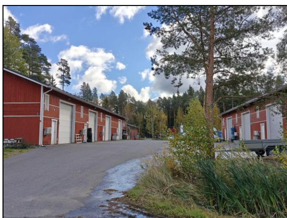
2010-luvun alkupuolella pystytettyjä hallirakennuksia.
