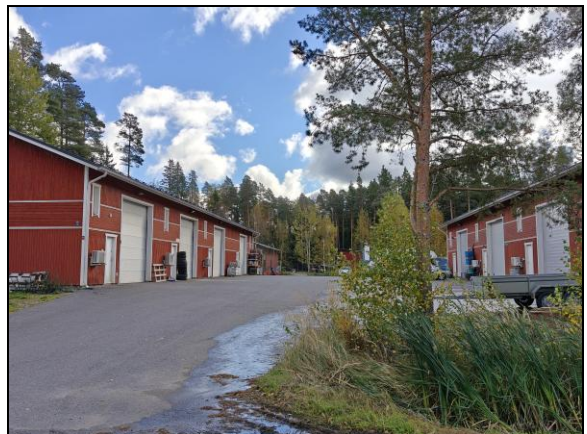
2010-luvun alkupuolella pystytettyjä hallirakennuksia.
