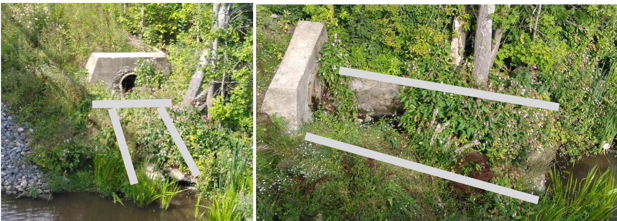
Kuva 3. Esimerkki hulevesipurkuputken betoniankkuroinnista joen törmään ja betoniuomasta jokeen. Kuva Turun Raunistulan sillalta.
